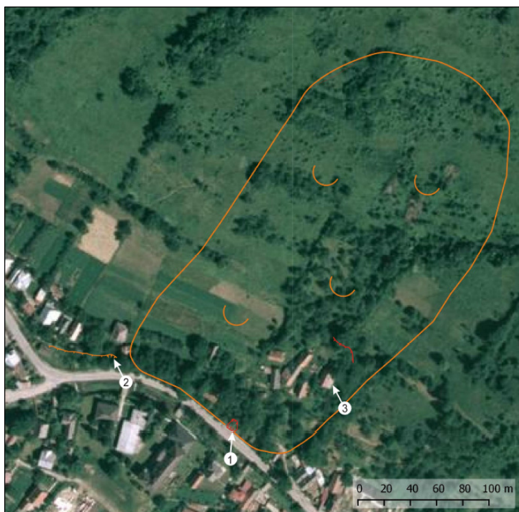
Obr. 8. Situácia zosuvu v obci Červený Kameň (GNSS merania): oranžová línia starý zosuv, červená línia aktívny zosuv, 1 – nový čiastkový zosuv (obr. 9, 11), 2 – starý čiastkový zosuv s odľazeným čelom, zabezpečený oporným múrom, 3 – poškodený rodinný dom č. 74 (obr. 10).
