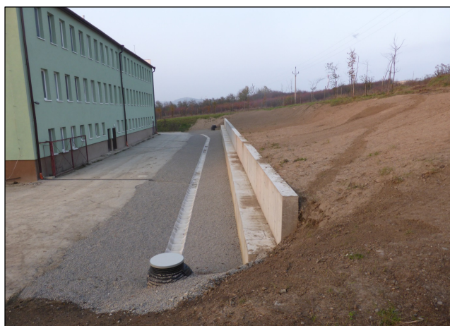
Obr. 3. Kotvená pilóťová stena zabezpečujúca svah nad budovou základnej školy v obci Nižná Myšľa (foto J. Šimeková).
