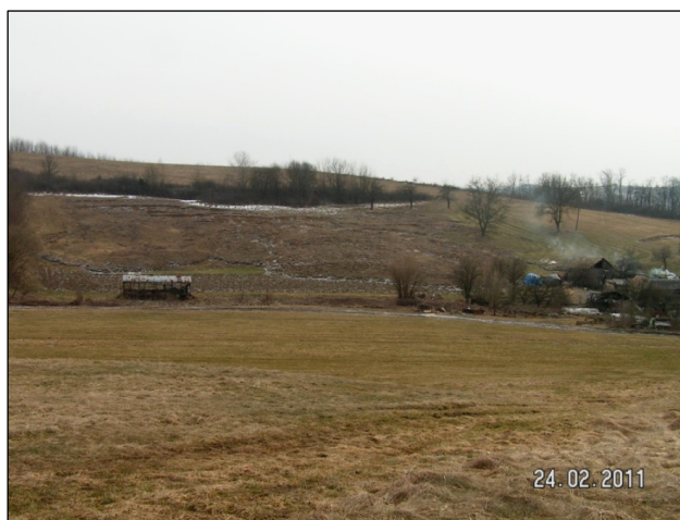
Obr. 6. Zosuv pri dome č. 93 (foto P. Liščák).
